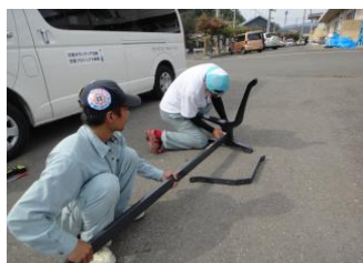
組み立て作業
