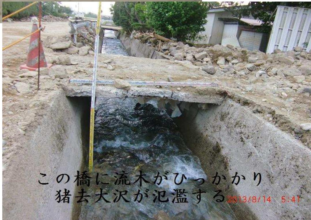
下の写真赤丸印内が流木がひっかかり、濁水が道路や宅地へ溢れている。
